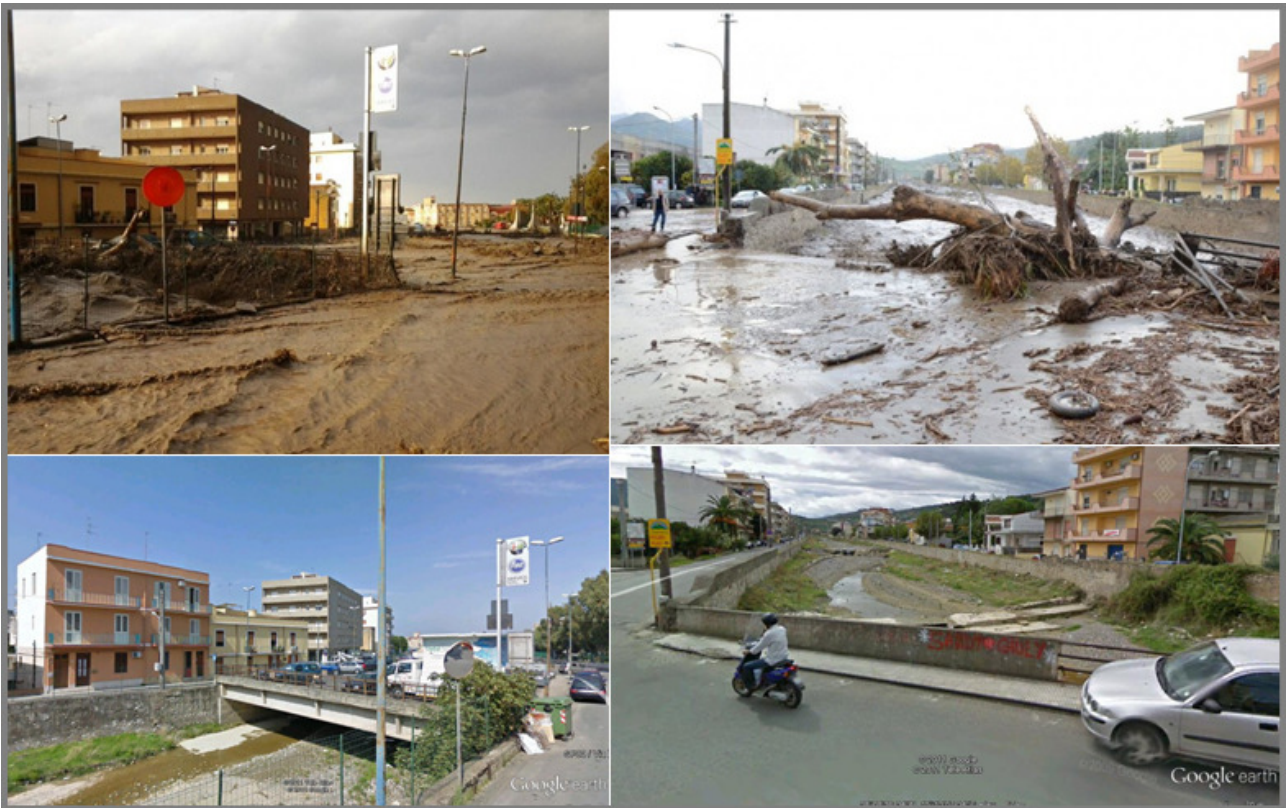
Figura 13: in basso e in alto a sinistra il torrente Longano in periodo di magra (in basso) e durante la piena del 22 novembre 2011. A destra in basso e in alto un viadotto rispettivamente in periodo di magra e dopo la piena del 22 novembre 2011 che ha causato l'accatastamento di tronchi d'albero d'alto fusto che hanno parzialmente ostruito la luce. Alcuni tratti dell'alveo della fiumara sono stati ricoperti per ricavare strade e parcheggi e hanno contribuito ad incrementare gli effetti devastanti della piena improvvisa.
