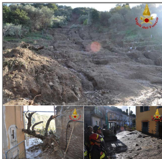
Figura 10: in alto è illustrata la fascia di versante denudata dal flusso fangoso; sono visibili i terrazzamenti antropici. In basso sono evidenti alcuni tronchi di ulivo e il fango accumulati lungo le strade.
