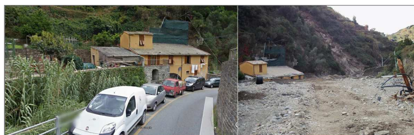
Figura 23: a sinistra la Strada Provinciale nella parte alta di Vernazza prima dell'evento, a destra dopo: è evidente l'accumulo di detriti che ha completamente colmato l'alveo e la strada stessa.
