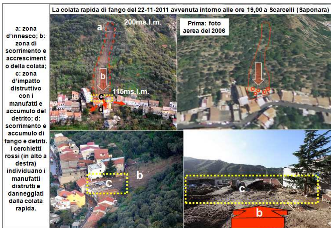
Figura 13: effetti della colata rapida di fango che ha interessato l'abitato di Saponara (località Scarcelli) lungo la fascia orientale dell'area più gravemente interessata dalle precipitazioni piovose.
