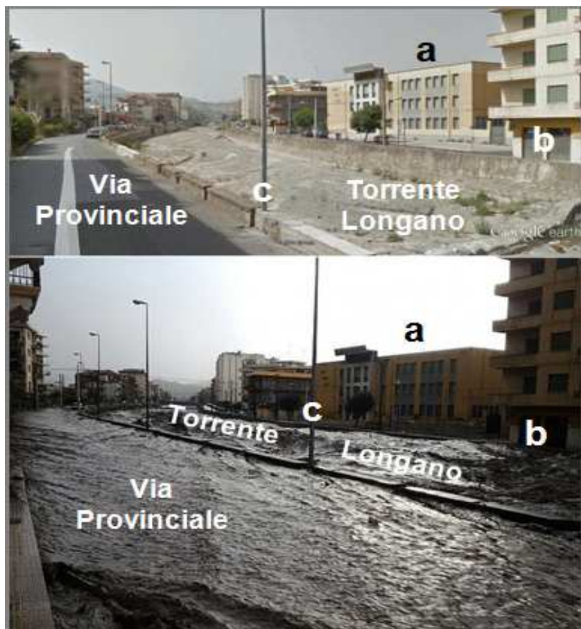
Figura 12: effetti dell'onda di piena riversatasi lungo il Torrente Longano all'interno dell'abitato di Barcellona Pozzo di Gotto.
