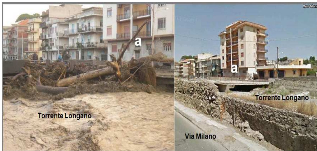
Figura 11: effetti dell'onda di piena riversatasi lungo il Torrente Longano all'interno dell'abitato di Barcellona Pozzo di Gotto. Sono evidenti gli sbarramenti al deflusso creati dai tronchi d'albero d'alto fusto.
