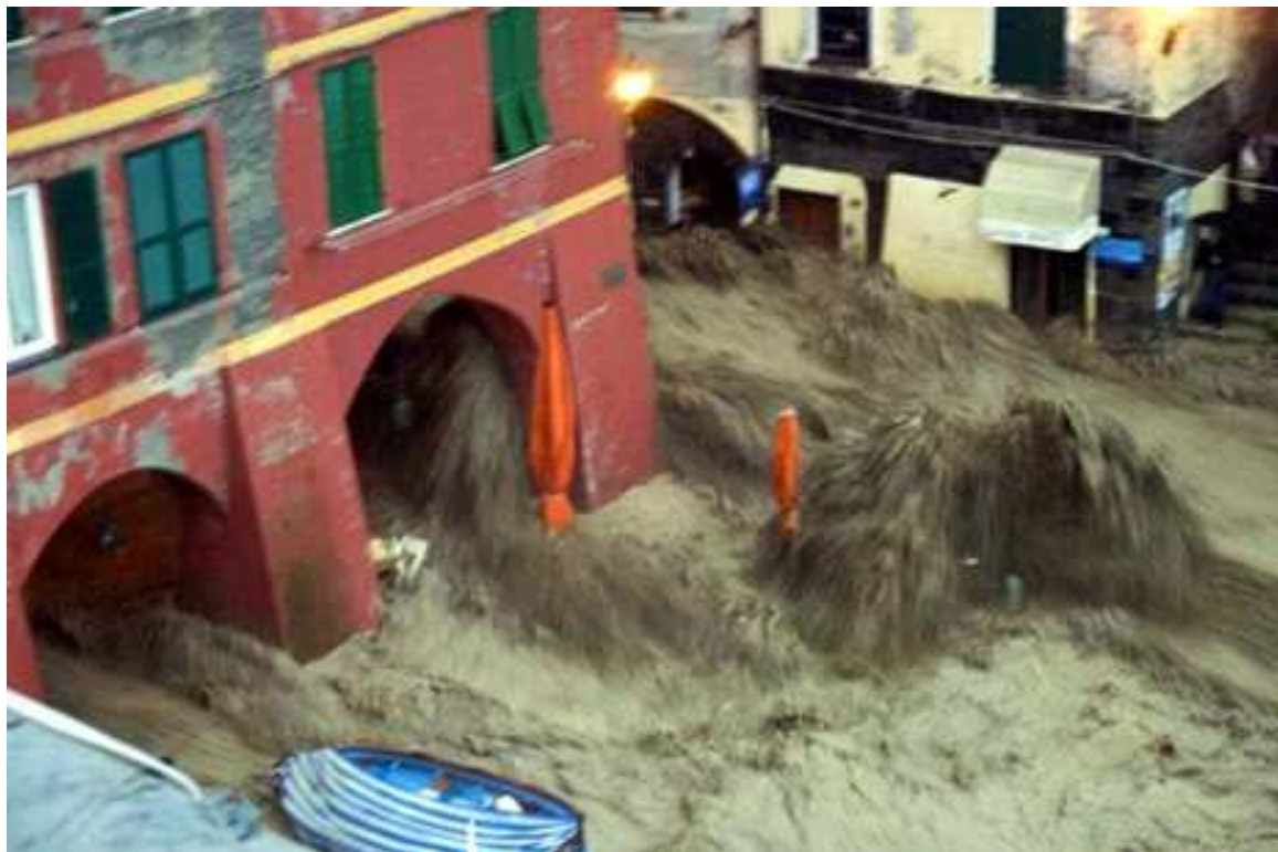
Figura 19: effetti del fenomeno alluvionale, nei pressi del porto, che ha devastato l'abitato di Vernazza senza preavviso.
