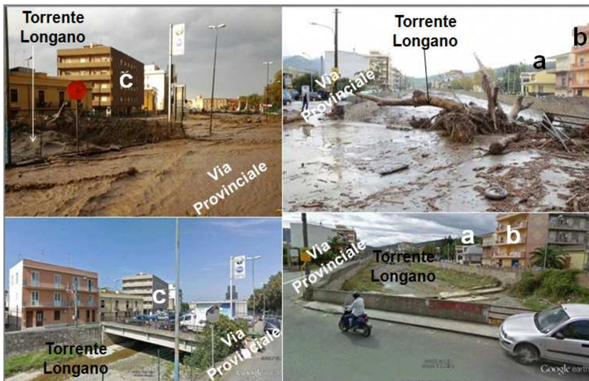
Figura 10: effetti dell'onda di piena riversatasi lungo il Torrente Longano senza alcun preavviso all'interno dell'abitato di Barcellona Pozzo di Gotto. Sono evidenti gli sbarramenti al deflusso creati dai tronchi d'albero d'alto fusto.
