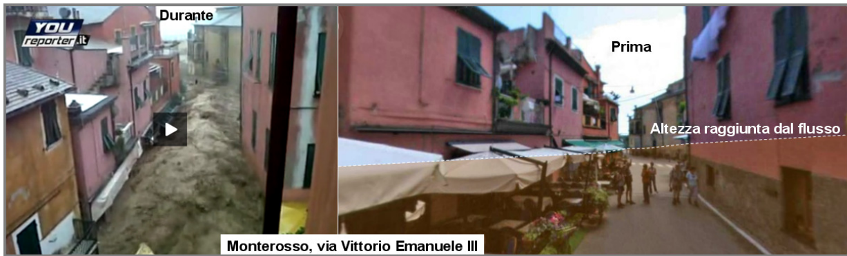
Figura 14: esempio dei danni causati dai flussi idrici, fangosi e detritici nell'abitato di Monterosso. L'isolamento dei locali al piano terra con porte a chiusura stagna potrebbe evitare i danni ai manufatti e alle attività economiche.
