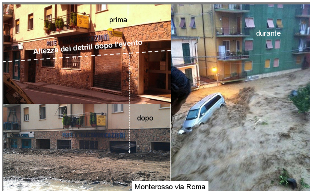
Figura 13: esempio dei danni causati dai flussi idrici, fangosi e detritici nell'abitato di Monterosso.
