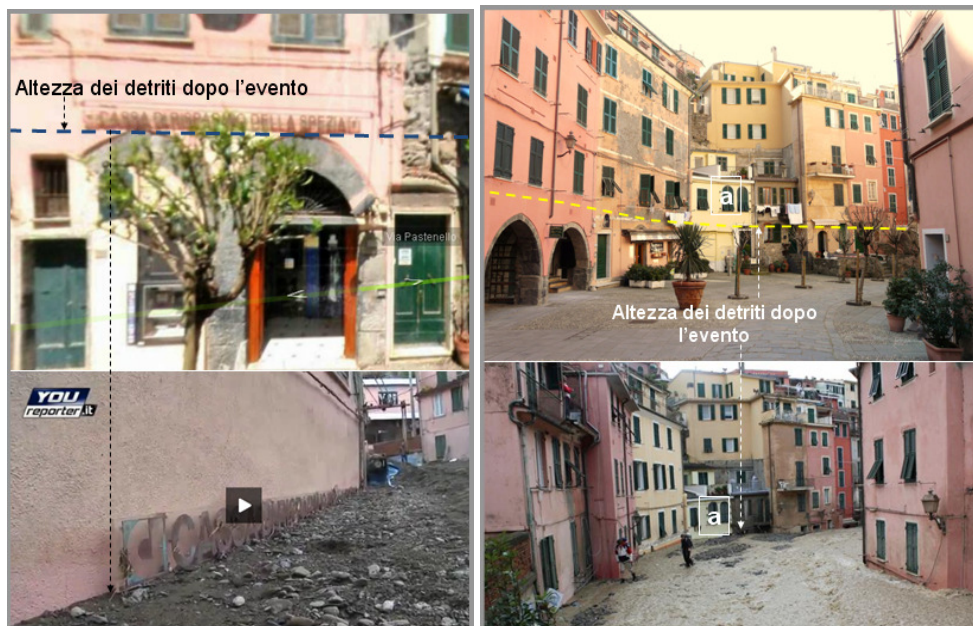
Figura 15: esempio dei danni causati dai flussi idrici, fangosi e detritici nell'abitato di Vernazza evitabili mediante l'isolamento dei locali al piano terra con porte a chiusura stagna.
