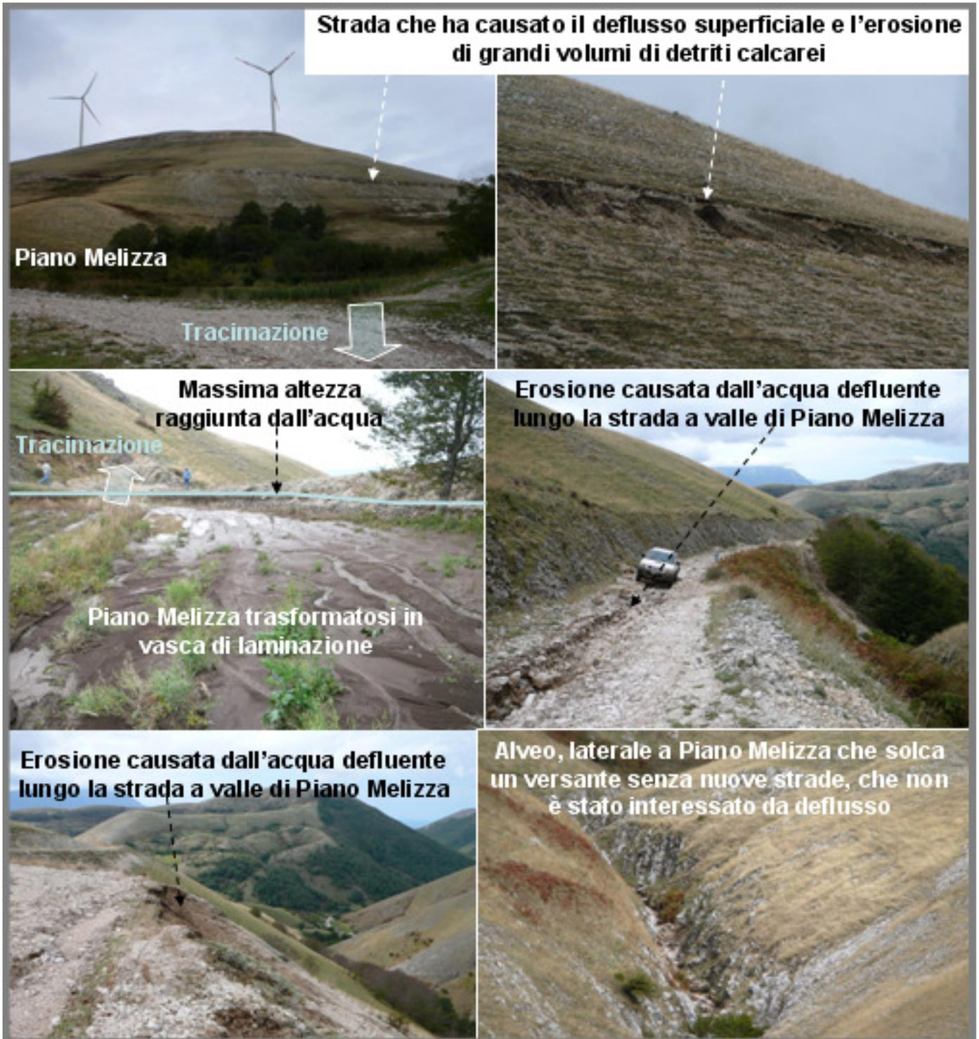
Figura 4: Esempio di inadeguata realizzazione di strade che hanno causato il potente flusso detritico di località Melizza.
